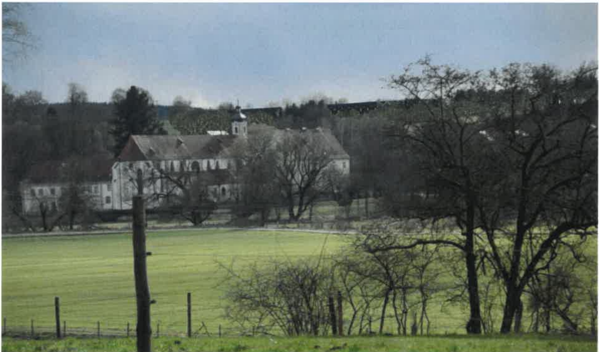
Abbildung: Fotomontage von nordöstlich des Plangebietes; Brennweite 130 mm (menschliches Auge ca. 33 mm) mit ca. 8 m hoher Bepflanzung
